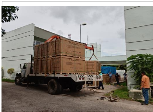
F1: Descarga de paneles e inversores
