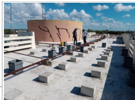
F3: Bases para soportería en azotea Biblioteca
