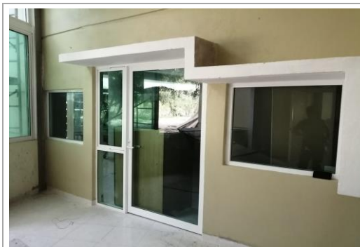
F5: Acceso a edificio 1a etapa desde planta baja
