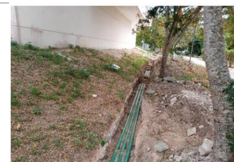
F4: Canalizaciones y encofrados
