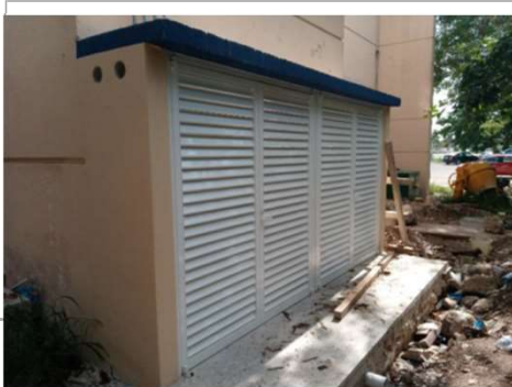
F3: Nicho en planta baja para inversores.
