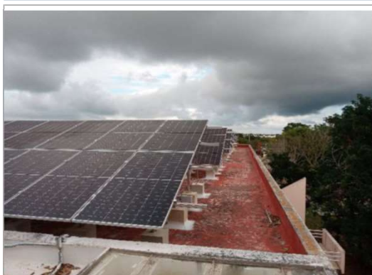
F1: Colocación de paneles en azotea de edificio de Aulas
