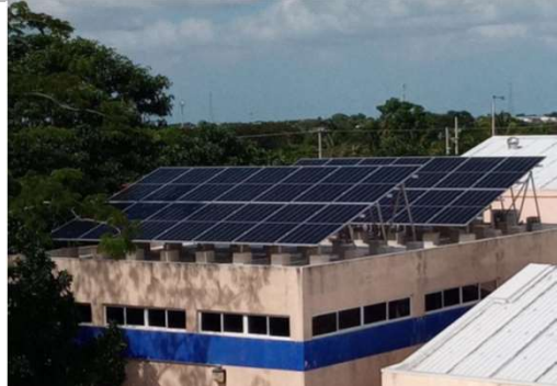
F4: Azotea Edificio "Sensorial"
