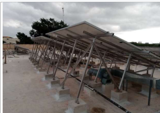
F2: Colocación de paneles en azotea edificio administrativo
